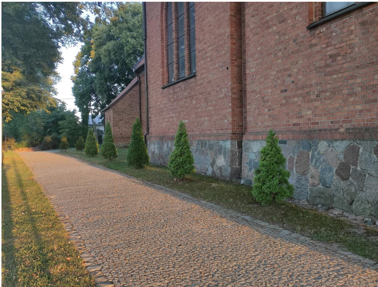
Widok od strony zachodniej
