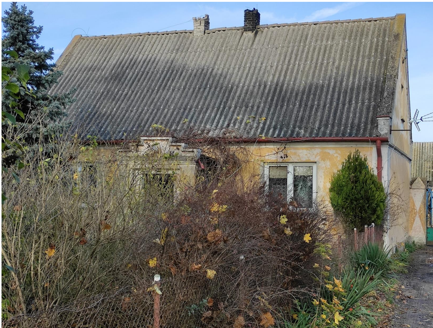
Widok od strony północnej
