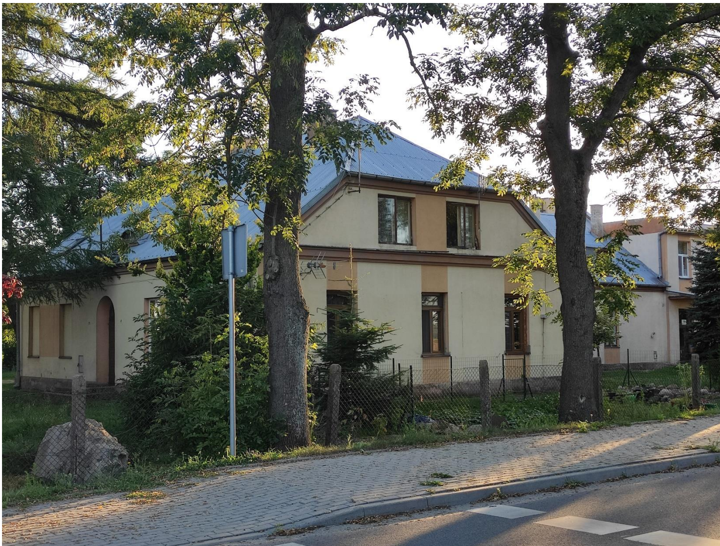
Widok od strony skrzyżowania dróg powiatowych
