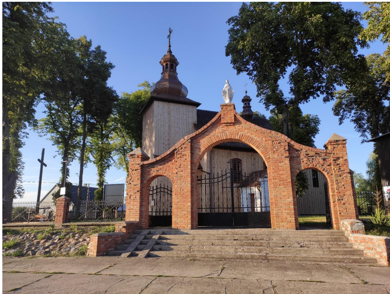
Widok od strony południowo-zachodniej
