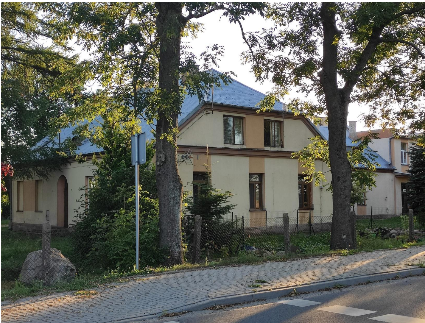
Widok od strony skrzyżowania dróg powiatowych
